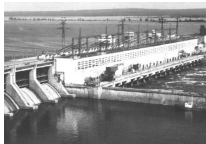
Начало строительство ГЭС весной 1954
