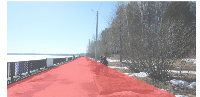
4. не разграничены потоки пользователей набережной
