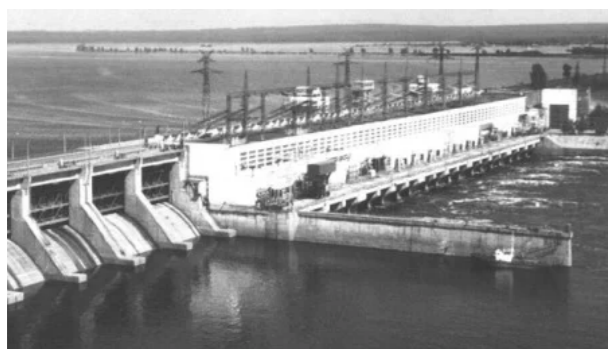
Начало строительство ГЭС весной 1954
