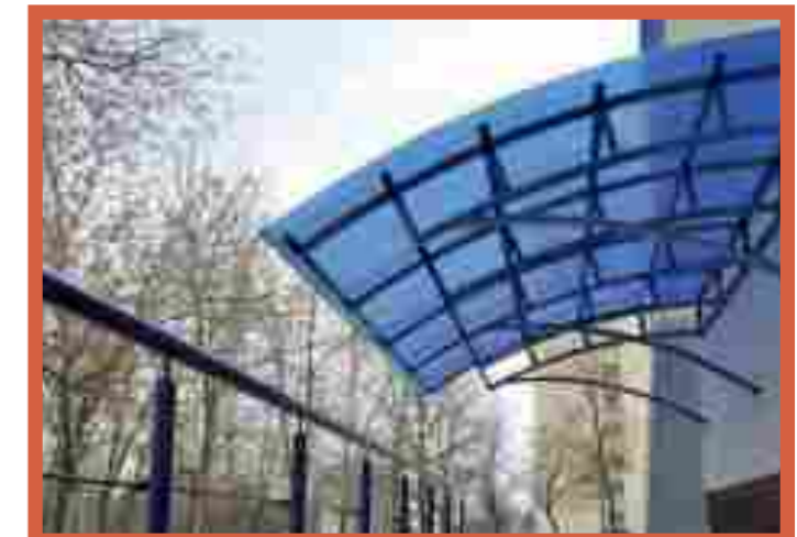
Козырек изогнутой формы и выполнен из цветного поликарбоната.
