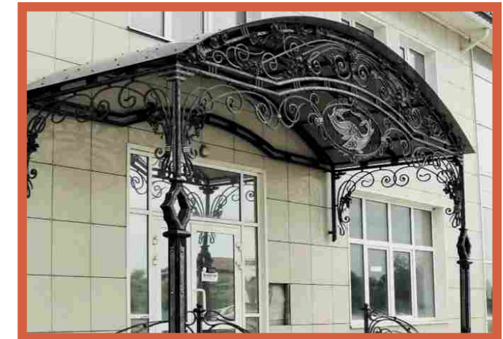
Козырек изогнутой формы и расположен на опорах.
