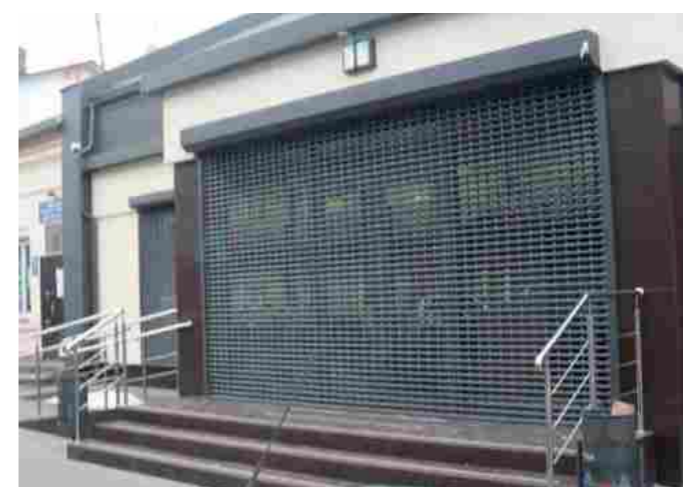
Использованы светопропускающие металлические роллеты.
